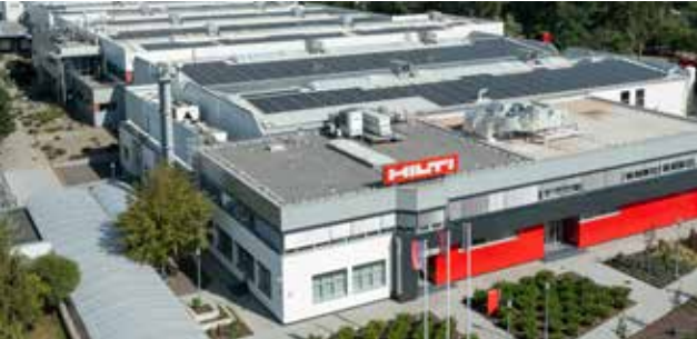
Hilti-gyár, Kecskemét - 33 db Hoval TopVent®, 9 db Hoval RoofVent® RP, 2 db Hoval ProcessVent®, 7 db hőszivattyú
