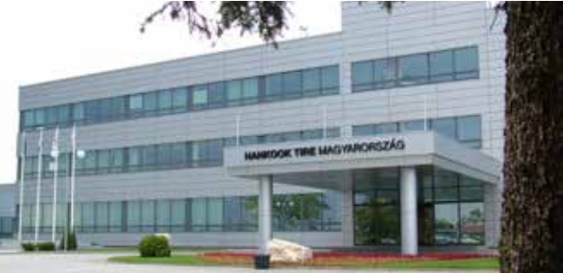
Hankook Tire, Rácalmás - 156 db Hoval RoofVent®, 47 db Hoval TopVent® TP berendezés
