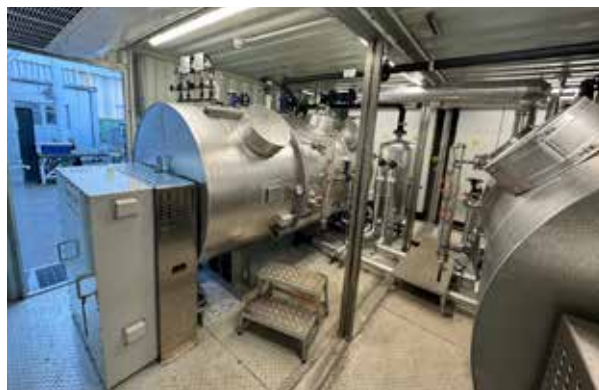
Alumínium extrudáló üzem - 2 db Ecotherm elektromos gőzkazán (1500 kg/h) konténer kazánházban
