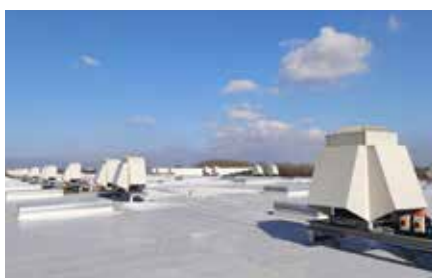
Halms csarnok, Debrecen - 22 db Hoval TopVent® TP hőszí- vattyús recirkulációs berendezés
