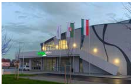
Sport és kulturális központ Sárovar - 2 db Hoval RoofVent® condens, 3 db Hoval TopGas®, 2 db Hoval S 1000 H
