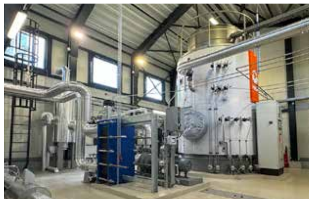
Alteo Nyrt. kazincbarcikai és tiszaujvárosi fűtőmű - 2 db, egyenként 6 MW-os Parat elektromos kazán
