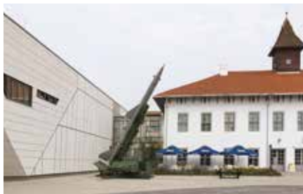
RepTár Repülómúzeum, Szolnok - 8 db Hoval TopVent® DGV és CAU berendezés
