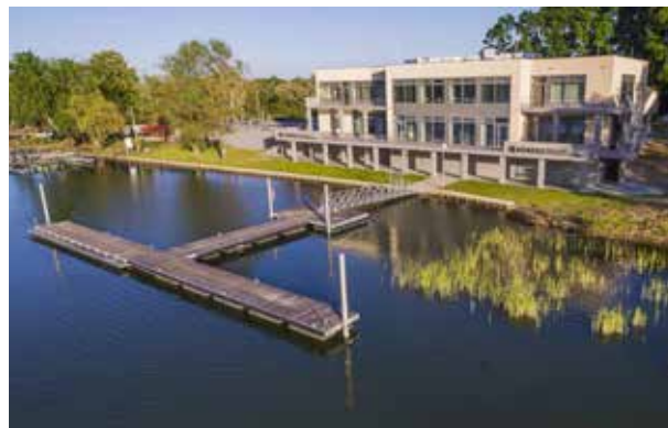
Kérész Központ, Tiszafüred - 2 db M-Tec WPS hőszivattyú, 1 db Hoval EnerVal puffertartály
