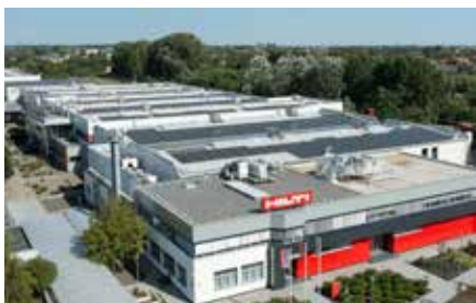
Hilti-gyár, Kecskemét - 33 db Hoval TopVent®, 9 db Hoval Roof- Vent® RP, 2 db Hoval Process- Vent®, 7 db Enerblue hőszivattyú
