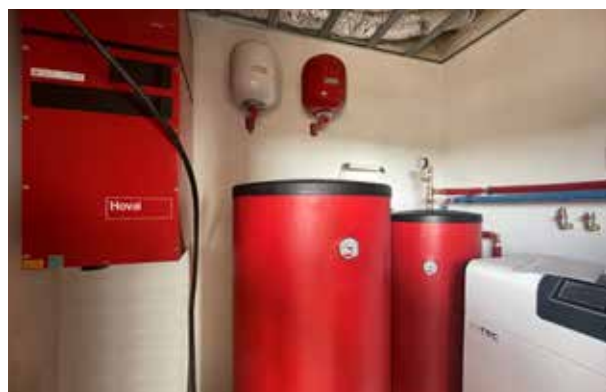
Családi ház, Budajenő - M-Tec hőszivattyú, Hoval CombiVal HMV-tároló és Hoval EnerVal puffertartály, Hoval HomeVent® lakásszellőztető
