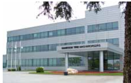
Hankook Tire, Rácalmás - 156 db Hoval RoofVent®, 47 db Hoval TopVent® TP berendezés
