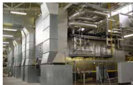
Dunapack Zrt., Dunaújváros - 4 db astebo THD-IZ túlhevített vízgőzt előállító kazán (55 t/h)
