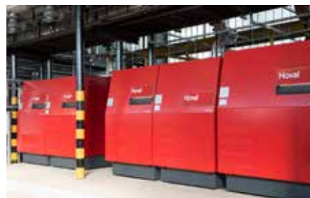
Mérges úti Fűtőmű, Gyöngyös - 3 db Hoval UltraGas® kondenzációs gázkazán
