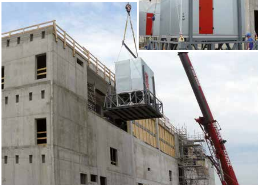
A készülékek elhelyezése egy 70 tonnás daruval történik. A hűtést 9 db ADK-30 típusú készülék szolgáltatja
