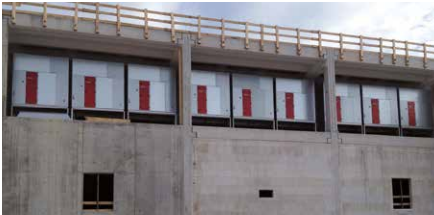
A készülékek elhelyezése egy 70 tonnás daruval történik. A hűtést 9 db ADK-30 típusú készülék szolgáltatja
