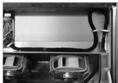
Kép: A vezetékek rögzítése a tetőegységben
