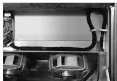
Kép: A vezetékek rögzítése a tetőkészülékben
